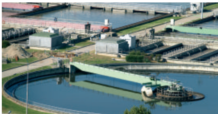
Estação de tratamento de águas
