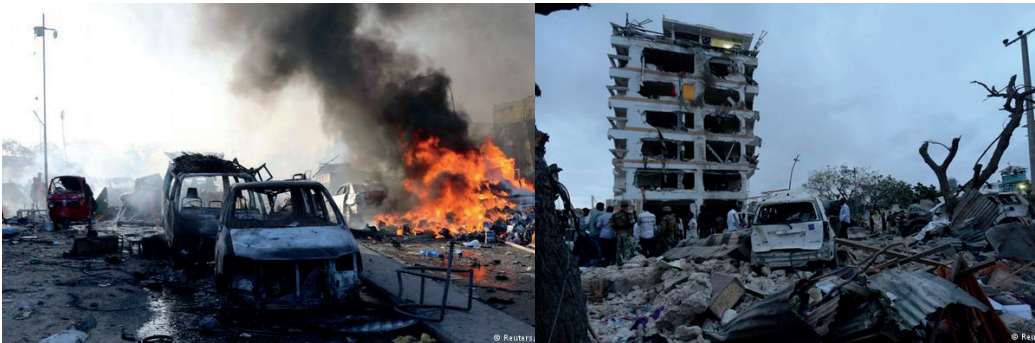
Fig. 30 Aspectos de destruição de Mogadíscio, capital da Somália, durante o conflito com a Etiópia.
